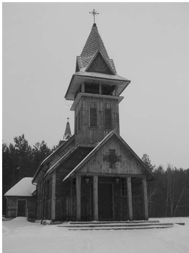
Budynek drewnianego kościoła zaadaptowany na salę konferencyjną
