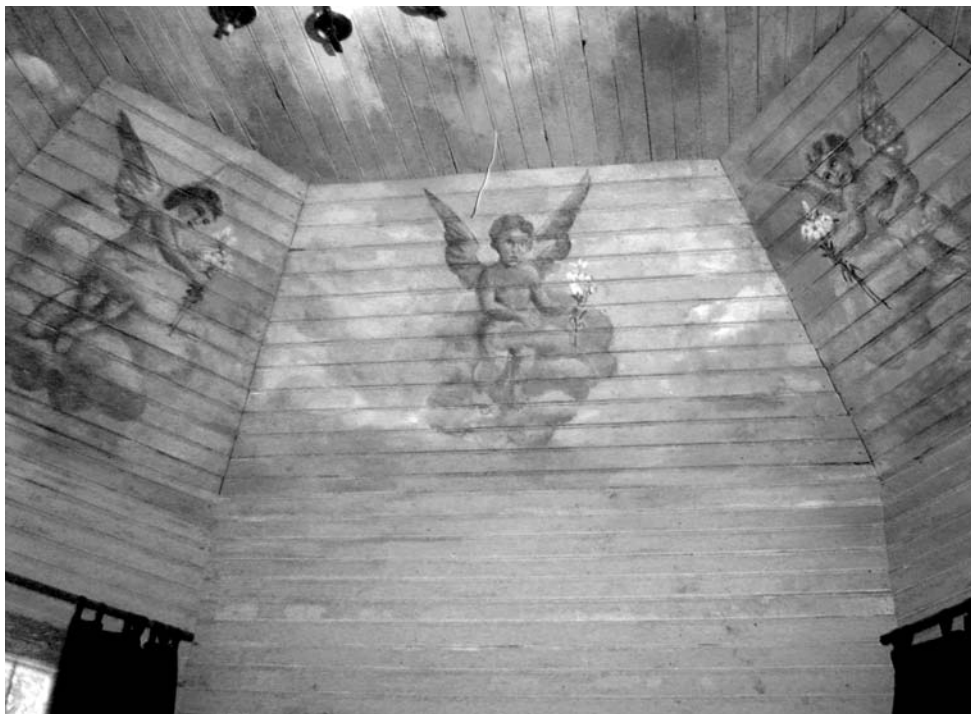
Fragment sufitu w budynku konferencyjnym
